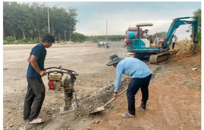
Hoàn trả mặt bằng sau lắp đặt tuyến ống dọc đường Tạo Lực Bắc Tân Uyên – Phú Giáo - Bàu Bàng
