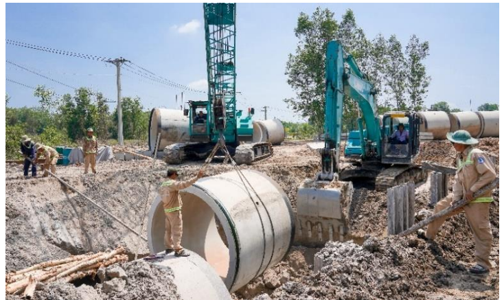
Thi công đường ống nước thô tự chảy lớn nhất Việt Nam
